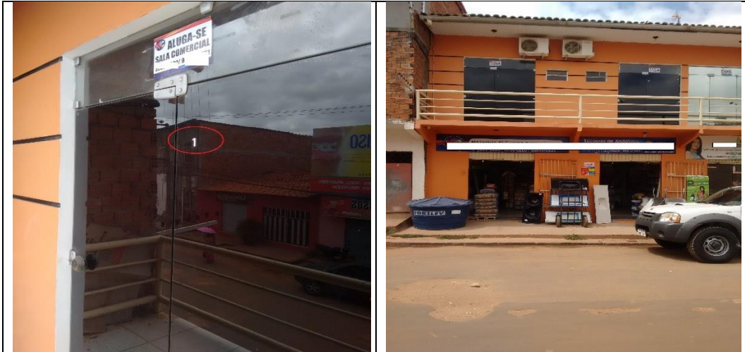
Foto - Box nº 01 (em destaque) do endereço Via Coletora 4000, nº 08, Quadra 105, Parque Vitória, São José de Ribamar (MA). Em 29/08/2016, São José de Ribamar (MA).
