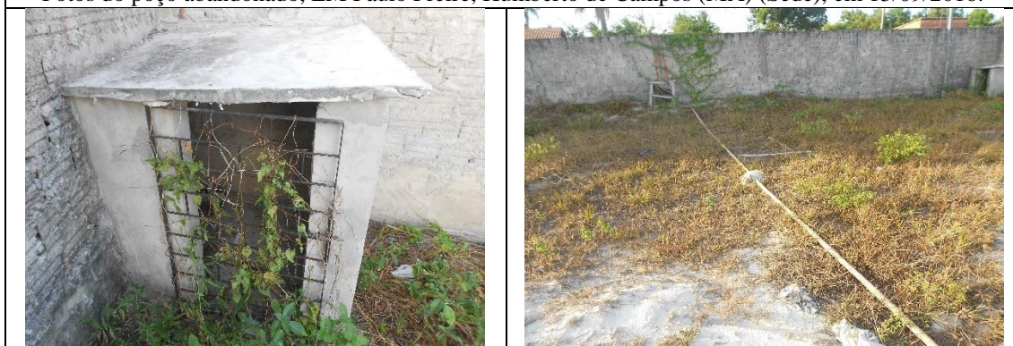
Fotos - Casa de máquinas e da tubulação colocada pela própria escola, em substituição ao poço, para trazer água da rua e abastecer a unidade, Humberto de Campos (MA), sede, em 13/09/2016.
